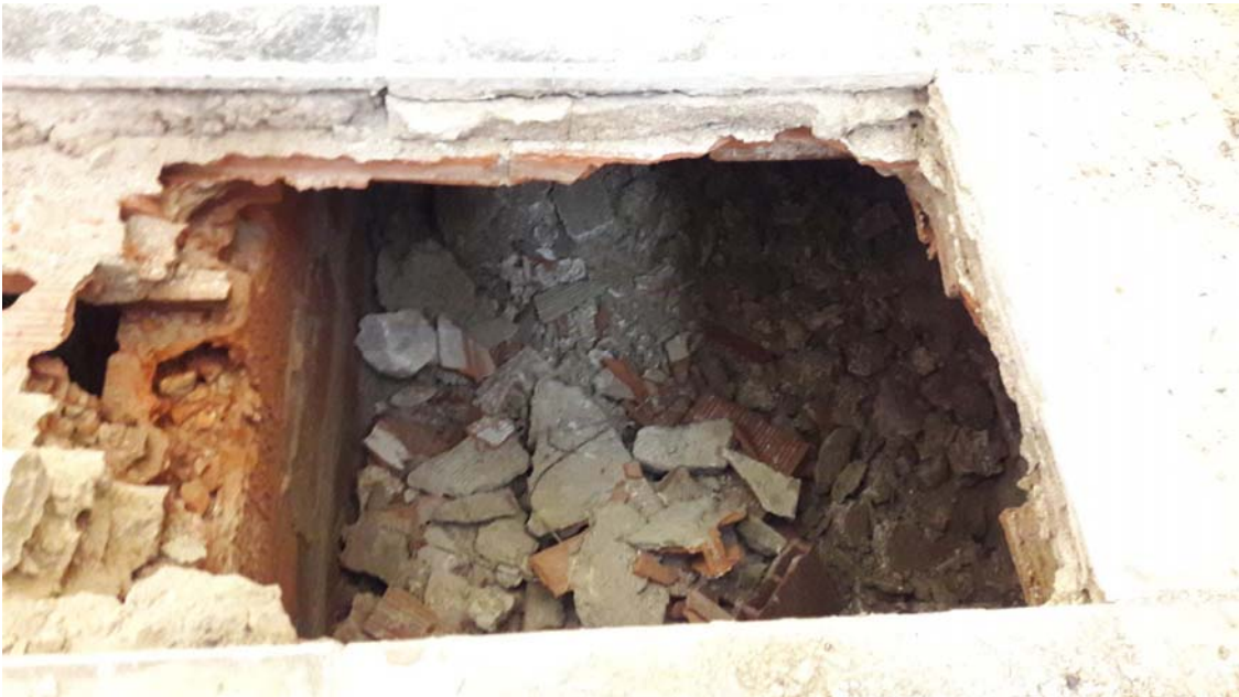
Solado retirado y debajo el forjado sanitario
