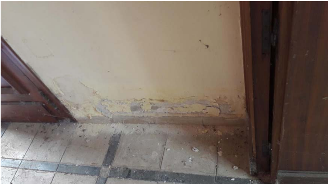
Filtraciones del terreno
