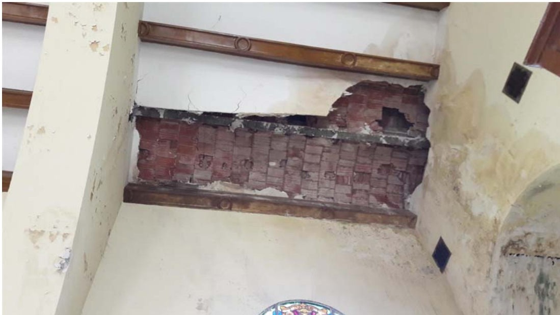
Desprendimientos de falso techo
