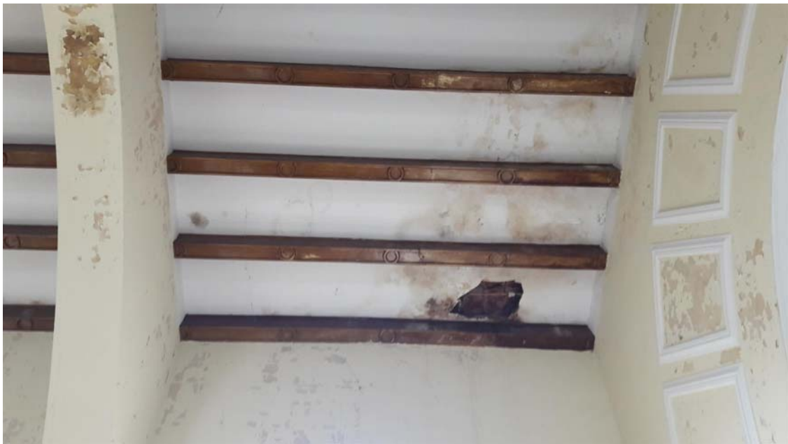
Filtraciones en paramentos verticales y desprendimientos de falso techo
