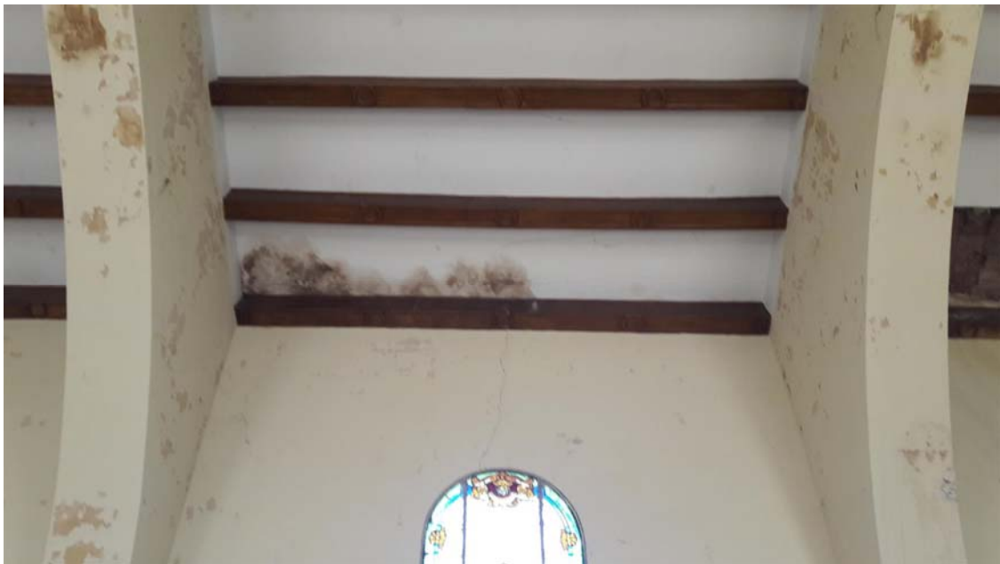
Filtraciones en falso techo
