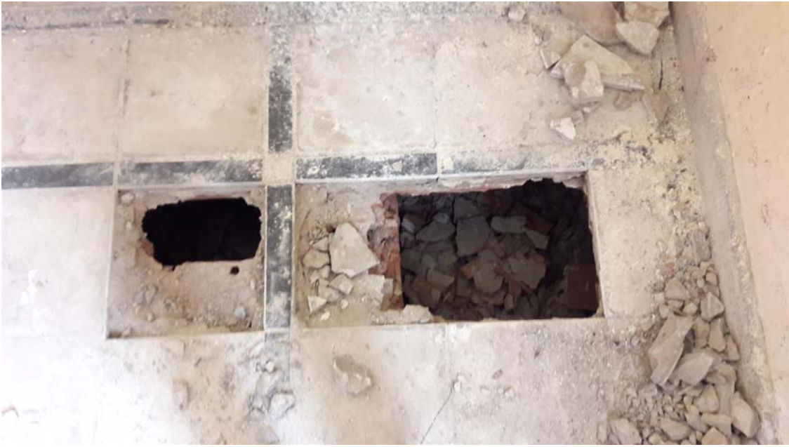
Solado retirado y debajo el forjado sanitario
